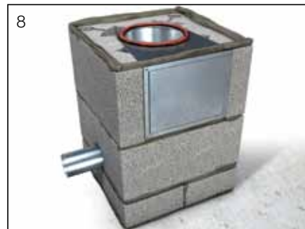
8 Etter at sotlukeelementet nå er på plass, bygges pipen opp videre med innerrør og ytterelementer. Husk det er meget viktig at klebermørtelen som brukes på innerøret, legges som en hel streng uten avbrudd. Tykkelse på klebermørtelen skal være ca 1,0 x 1,0 cm. Tykkelsen for mørtel på ytterelement skal være ca 2 x 2 cm rundt hele ytterelementet.
