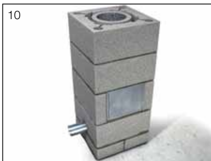
10 Ytterelement og innerrør mures vekselvis. Kontrollér lodd og vater for hvert element.
