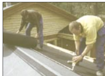
Fugemasse som sikring i omlegg.
