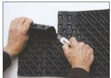
Rillene virker som skjæreanvisning.
