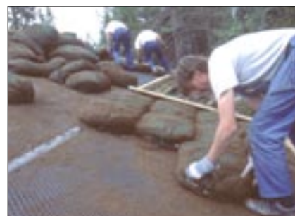
Rillene gir friksjon for torvlaget.
