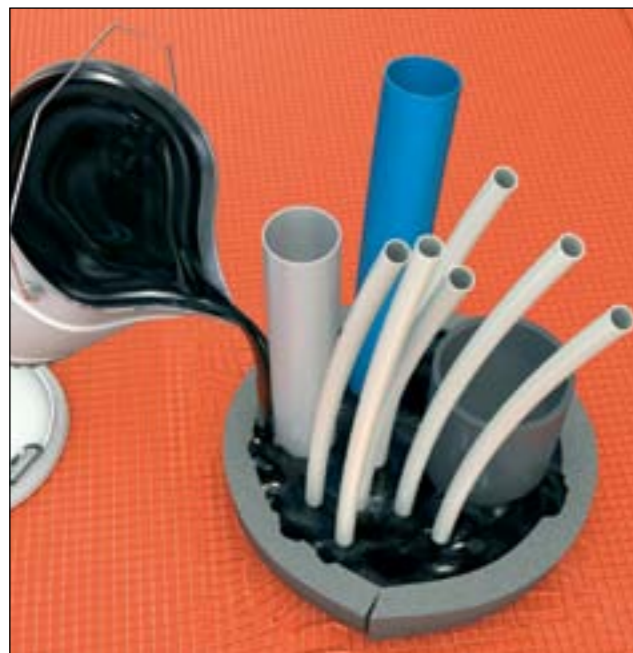
15. Gjør alltid klar forskalingen på forhånd. Husk å gjøre rent hele området med teknisk sprit før du monterer forskaling og fyller opp med Easi Pour Radon tettemasse.
